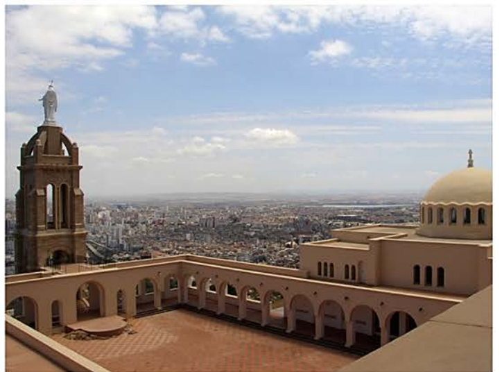
2018 – Réception des travaux
