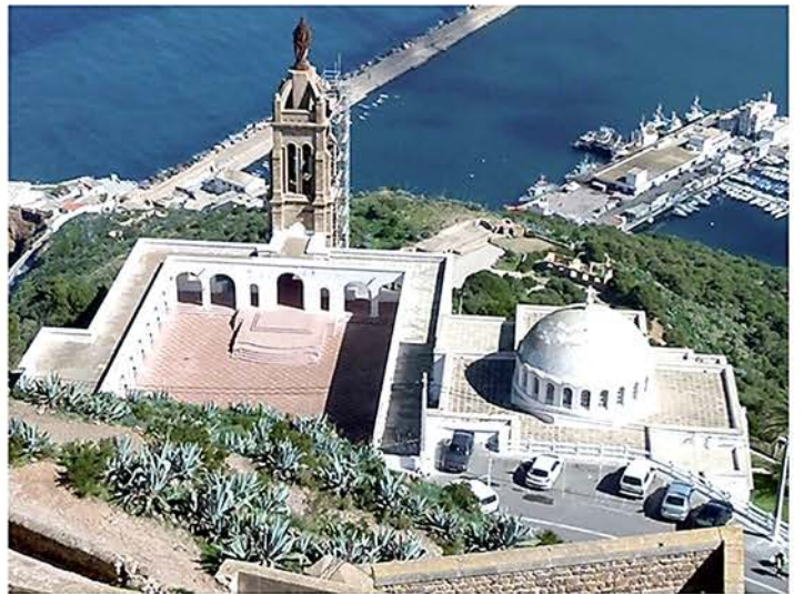
1960 – Fin des travaux. Le projet de la chapelle restera inachevé
