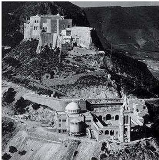
1959 – Les travaux sur le mur de soutènement restent à terminer
