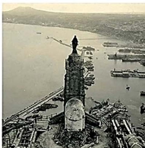
1950 – Terrassement de la plateforme ; démarrage de la construction des galeries
