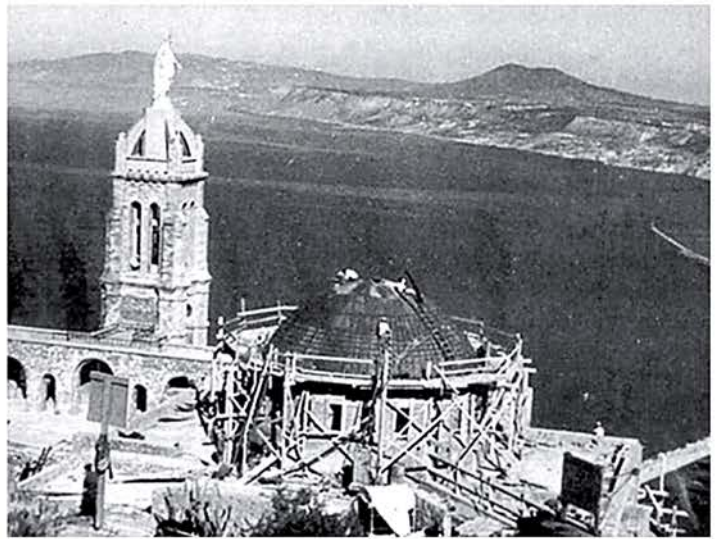
La construction du dôme L'arc de la façade ouest de la tour a été bouché
